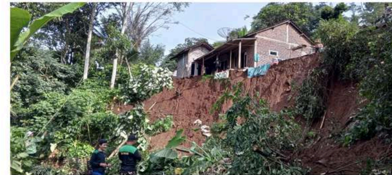
Rumah di pinggir tebing yang berisiko longsor bila terjadi longsor susulan di Dusun Kedawung, Desa Karangwuni, Kecamatan Pringsurat, Temanggung (ADDIN ALFATH/ JAWA POS RADAR MAGELANG)
