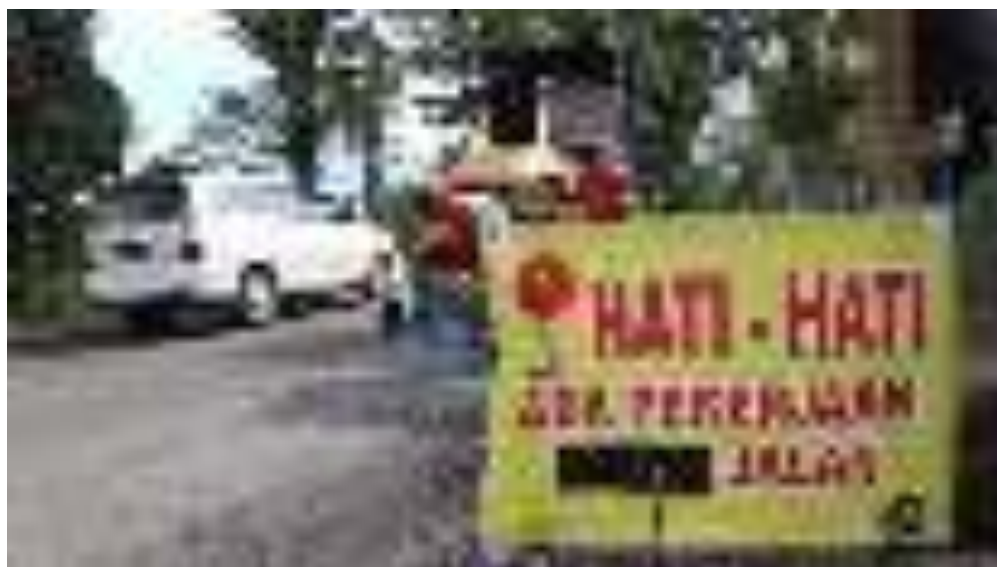
Gambar 2.38 Perbaikan Jalan Lingkar Temanggung Tahun 2022
